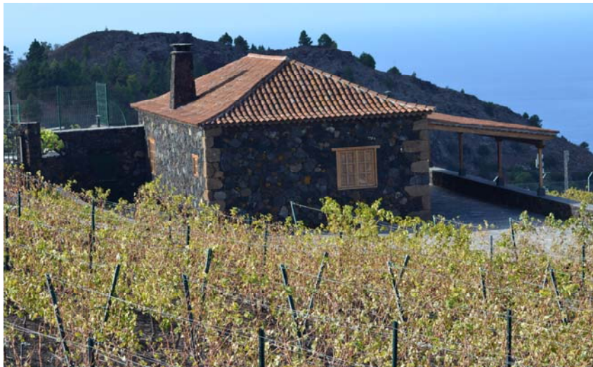
Bodega de reciente planta que conserva elementos tradicionales de construcción, viñedo reestructurado en espaldera. Las Manchas, El Paso. A comienzos del S. XXI.
